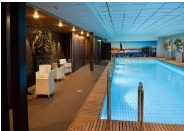
Kuva 62. Hotellin alemmassa kellarikerroksessa uima-altaan päälle rakennettiin uusi välipohja, jolloin ylempään kellarikerrokseen pystyttiin luomaan kokoustilakerros. (Kuva: Projekt uutiset 6/2016)
