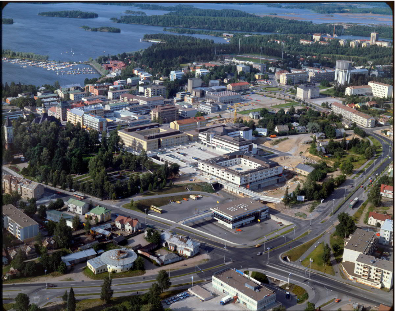
Kuva 3. Vasta valmistunut aukiokokonaisuus Kirkkopuiston itäpuolella. Hotelli Lappeen ympärillä ovat vielä kaksitasoisen ajoneuvoliikenteen uudet liikennejärjestelyt kesken ja yksi vanha rakennus on jäänyt hotellin kaakkoiskulmalle. Kauppakeskus Iso-Kristiinaa ei vielä ole. Etualalla 1960-luvun puolella valmistunut linja-autoasema, jonka paikalle rakentui myöhemmin kauppakeskus Galleria. (Lappeenrannan museot/ Finna/ Sky-foto 1984-85)
