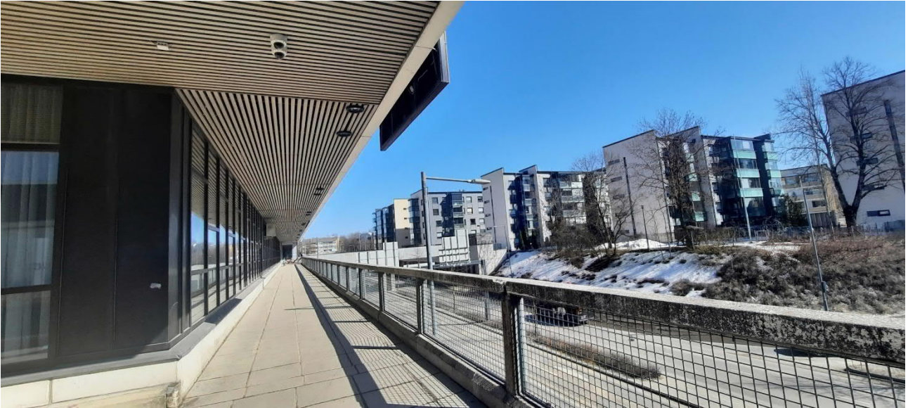
Kuva 76. Lappeenkadun puolella on ulokkeena toteutettu jalankulkuyhteys. Toinen ja kolmas kerros kiertää kolmen metrin ulokkeena koko rakennuksen. Tämä ei toki enää hahmotu kauppakeskukseen yhdistetyn osan kohdalla. Alumiinisälekatot ovat ajalleen tyypilliset.
