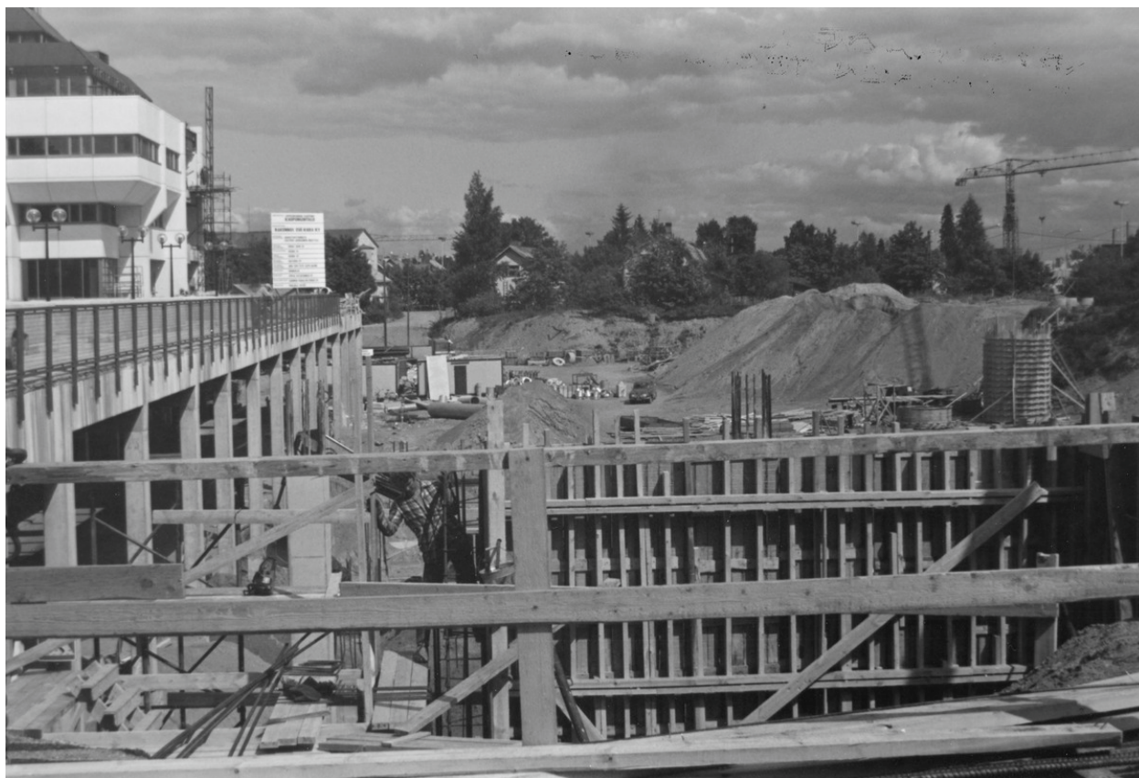
Kuva 11. Hotelli Lappee rakenteilla. Vasemmalla kaupungintalo. Monttu ja aukion tukirakenteet kertovat useaan kerrokseen jaetun liikenteen ja paikoituksen mittasuhteista. (Lappeenrannan museot/Finna, tuntematon kuvaaja)
